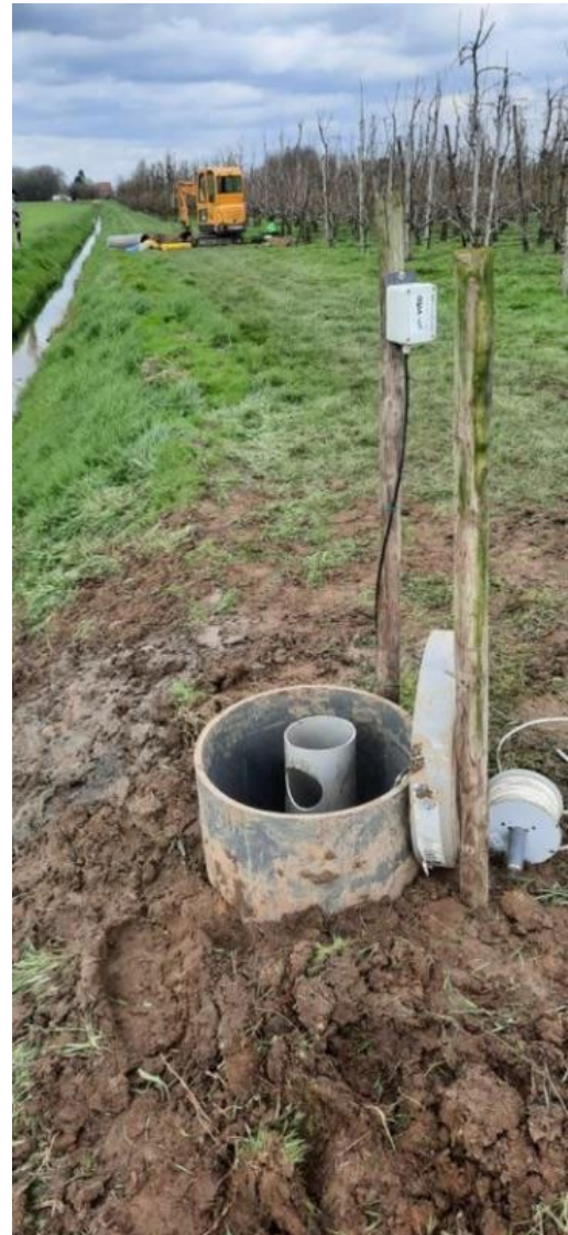
Regelput peilgestuurde drainage in een boomgaard
